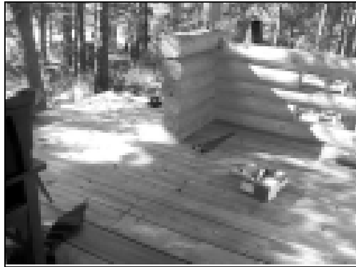
Talkotyönä rakennetun hirsisen kalamajan terassikin on valmis. Portaat vielä puuttuvat.
