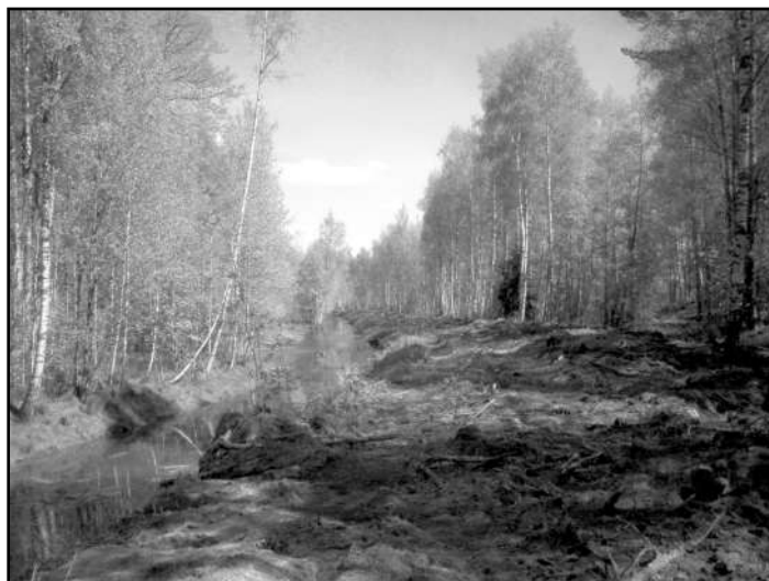
Tästä on kaivinkoneet menneet. Ojanpientareen risukon paikalla on pohjan lietettä.
