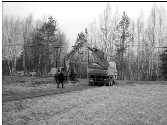
Torsti Taari hakemassa kaivinkoneen aluslevyjä. Aimo Jaakkola kaivinkoneen puikoissa.
