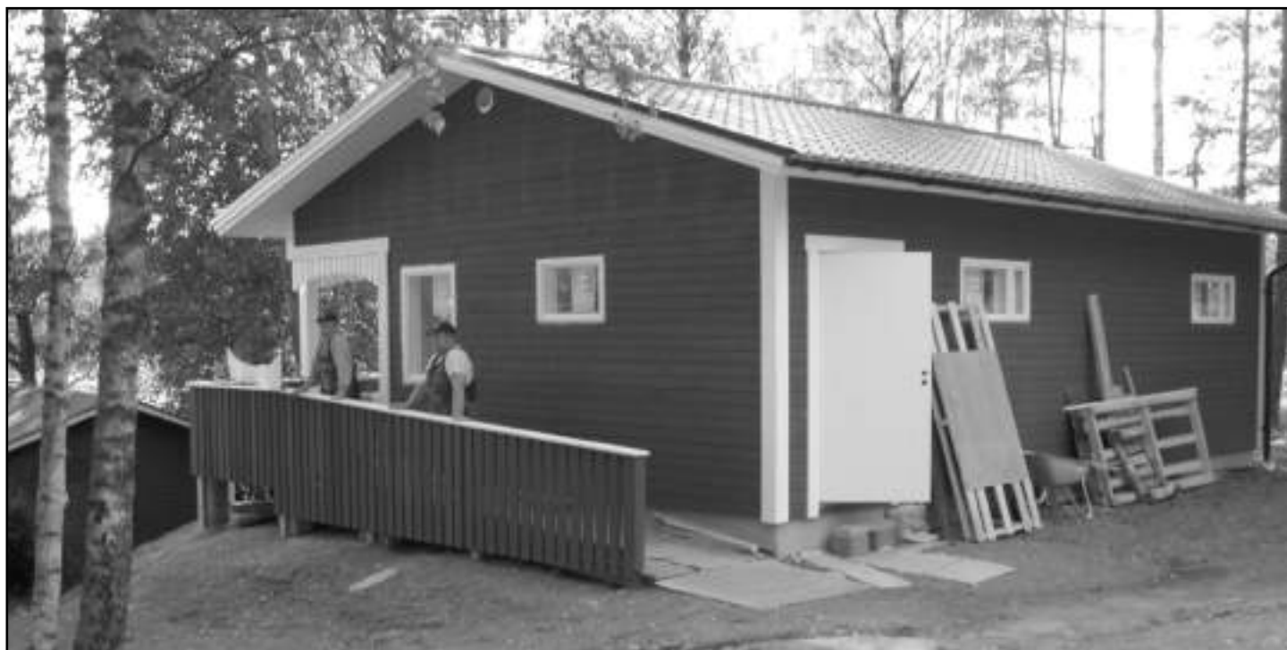
Jartti Malmi ja satunnainen vierailija tuumailtatuolla saunan sisääntuloluiskalla, jonka 5 asteen kallistumaa pääsee hyvin pyörätuolilla.
