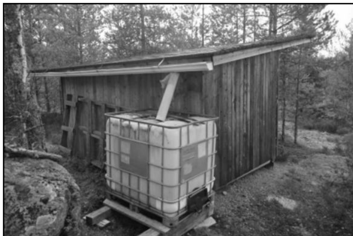
Saniteettitilojen takana on vedenkeräin tulipalon varalta.
