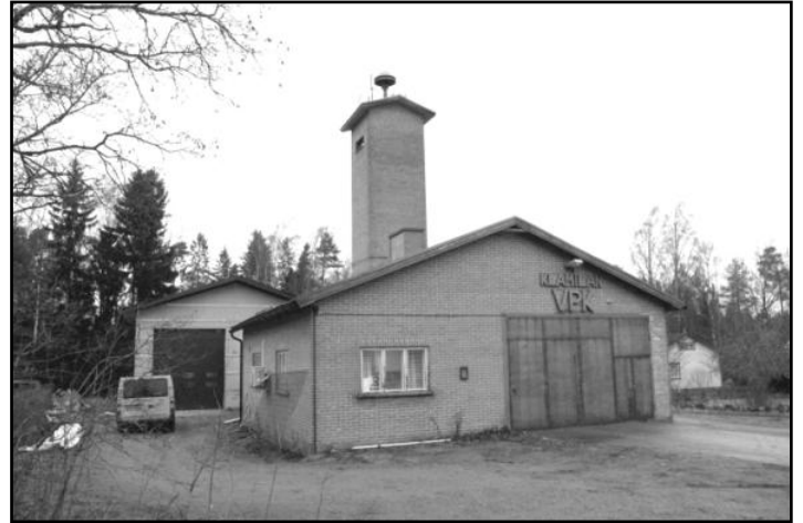
VPK:n rakennukset Klamilan Salea vastapäätä. Takana uusi kalustohalli.
